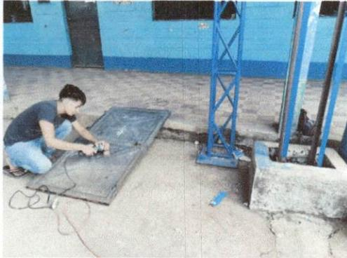
Foto1: Mejoramiento de estructura portón de suministro de costanera tipo C lijado y pintado.
